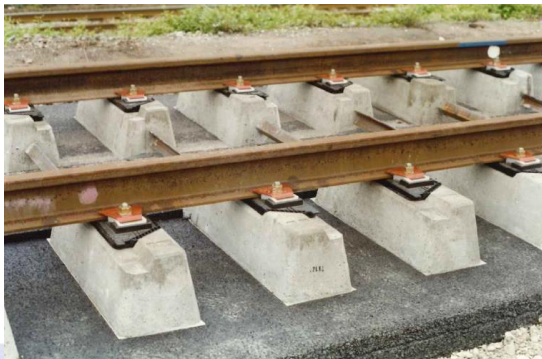
Pose de VSB (Lingolsheim, France)
